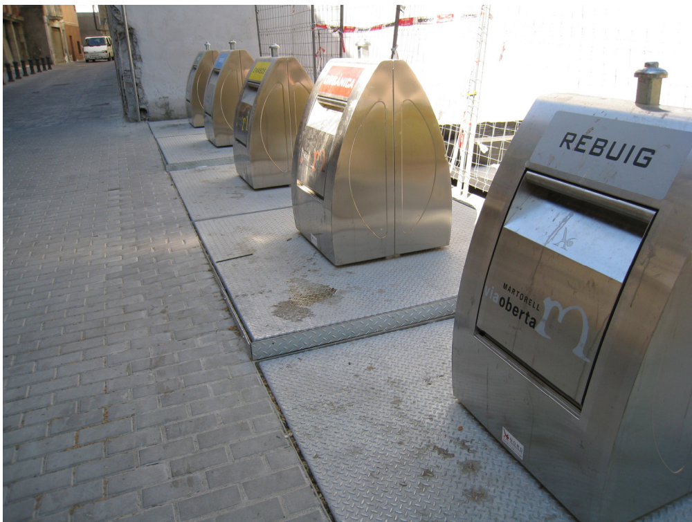
Instal·lació de contenidors soterrats en el barri de la Vila
