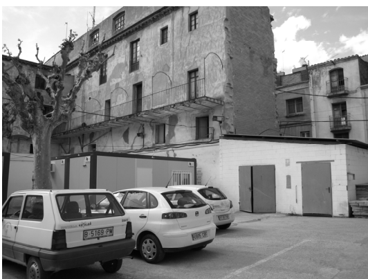
Terrenys de l'antic Hospital
