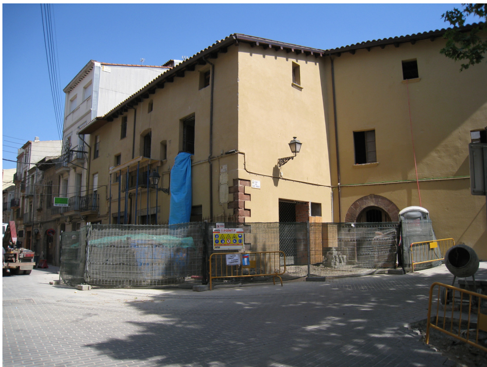
Rehabilitació de la Casa Par
